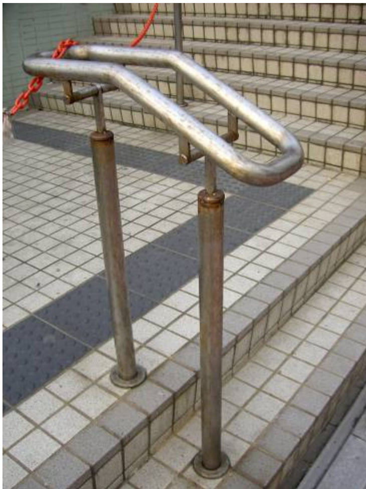
圖 1.45 不銹鋼製成的扶手
