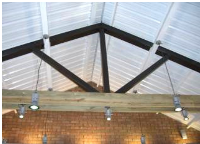
圖 1.12 平面框架 - 屋架
