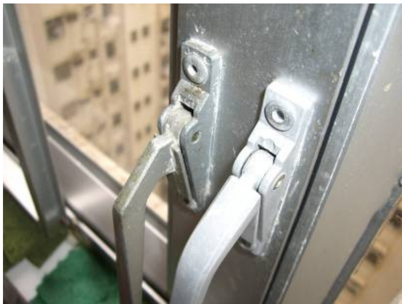
圖 1.44 鋁合金造成的窗框
